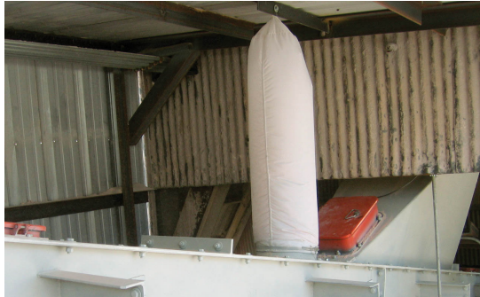
La bolsa colectora de polvo MARTIN® esta disponible con una bolsa estándar o una bolsa disipadora de estática para uso en ambientes explosivos.
